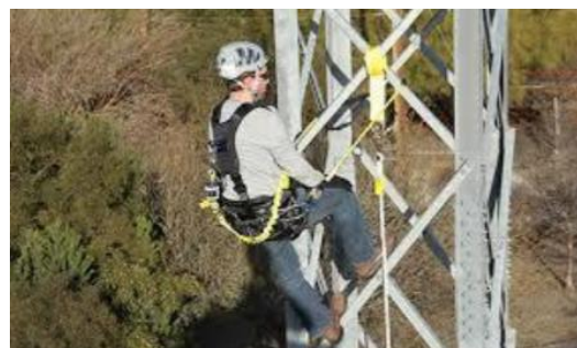
Figura 1 – Eletricista realizando a manutenção de uma torre.
