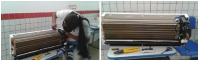
Figura 2 – Arduino e Processo de instalação
