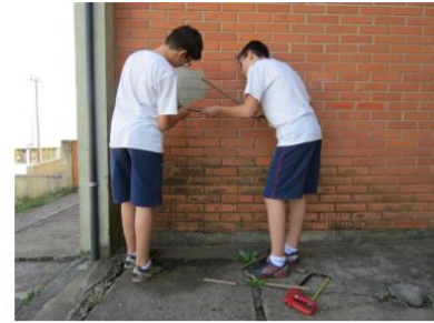
Construção da estrutura de canos – pensando no local
