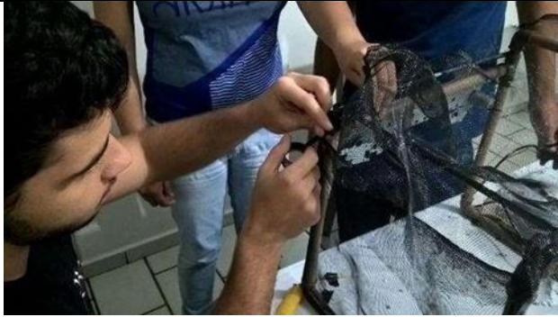
Figura 299 - Fixação da tela de proteção
