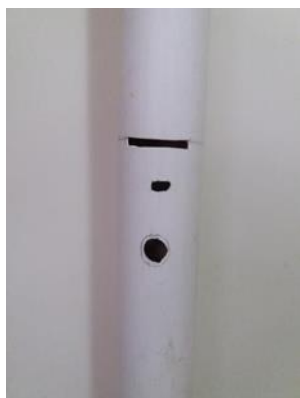
Figura 133 - Aberturas feitas no cano de PVC 100mm
