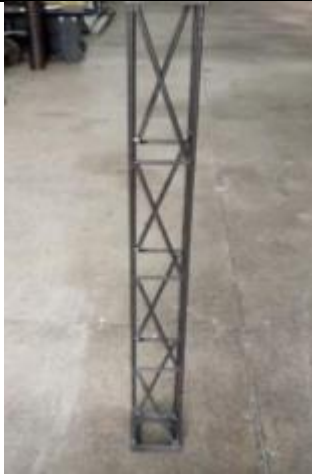
Figura 665 - Processo final da soldagem e colocação das hastes transpassadas para formação da torre (estrutura da Grua).
