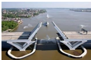
Figura 11 - Ponte Woodrow Wilson, nos EUA.
