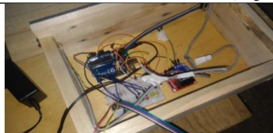
Figura 21 - Instalação do Arduino e componentes eletrônicos.
