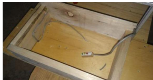
Figura 22 - Instalação dos semáforos.
