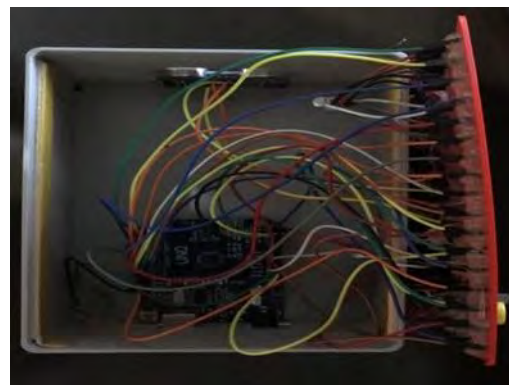
Figura 3- Parte interna do box
