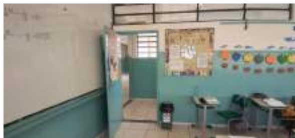
Figura 5- Ventilação Natural- abertura de porta e janelas da sala de aula
